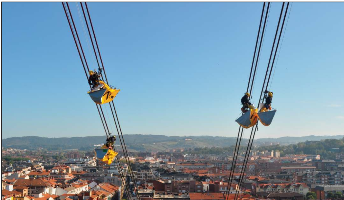
Técnicos Verticales de la Cooperativa Asaken pintando los cables de anclaje de la margen derecha
