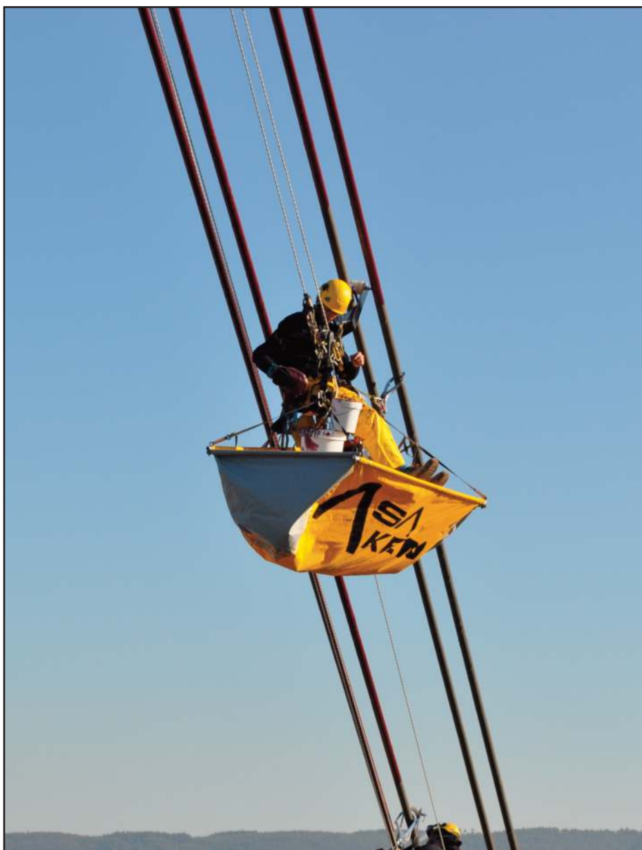
Las labores de pintado de los tensores comenzaron a las 8.30h
